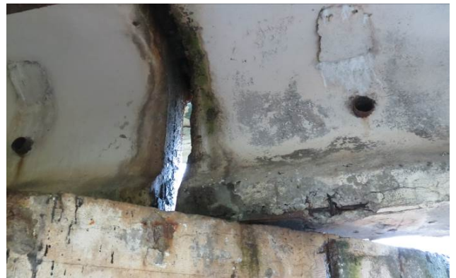
2.10 pav. Pirmojo ir antrojo tarpatramių perdangų aštuntų sijų galai virš antros atramos. Sijų galus nuolat drėkina vanduo pratekantis pro šaltilčių konstrukciją. Antrojo tarpatramio perdangos 8 sijos gale supleišėjęs apsauginis betono sluoksnis, koroduoja armatūra
