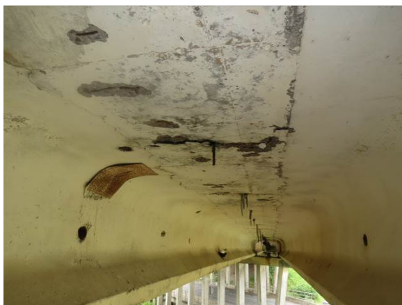
2.7 pav. Hidroizoliacija yra pažeista. Tarp kraštinių sijų plokštėje ir po šaltilčiais išsisunkę karbonatiniai produktai
