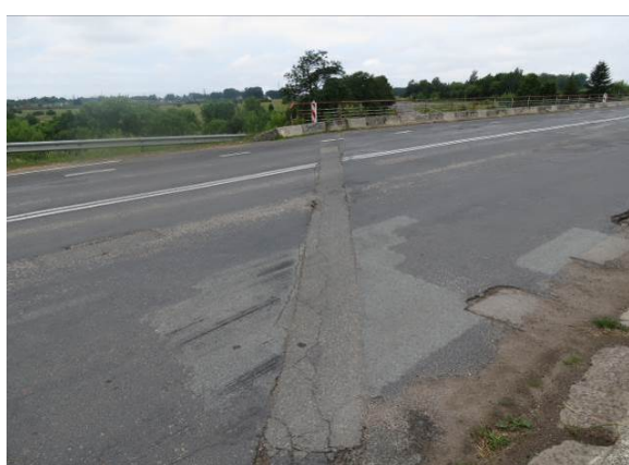
2.2 pav. Kiauras deformacinis pjūvis virš pirmos atramos
