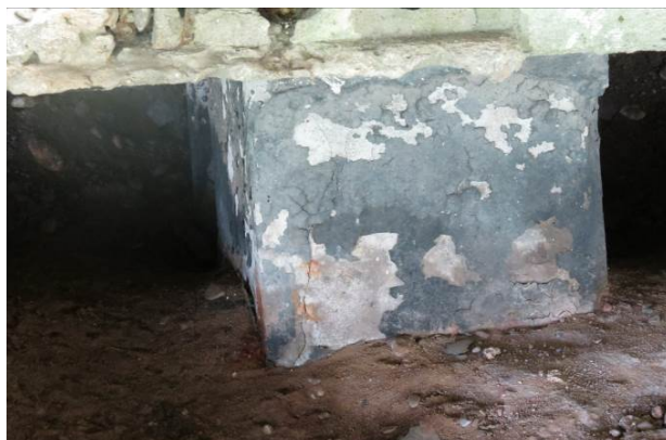
2.27 pav. Papleišėjęs 1 atramos 1 poliaus (po antra sija) apsauginis betono sluoksnis
