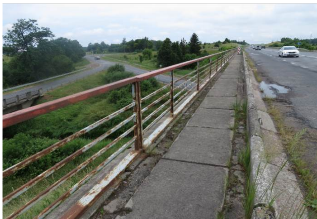
2.6 pav. Atitvarų bendras vaizdas kairėje pusėje. Ženklėjimas nusitrynęs, paviršiai nusidėvėję
