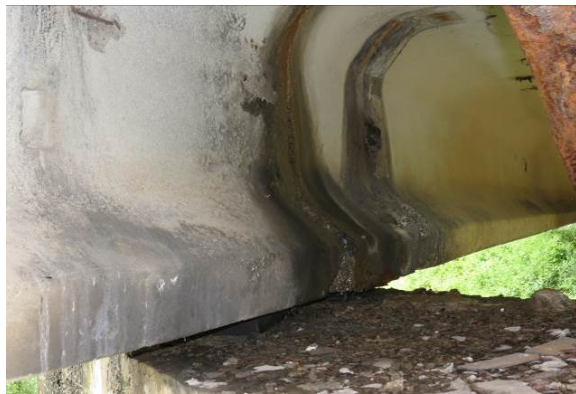
2.9 pav. Pirmojo ir antrojo tarpatramių perdangų pirmų sijų galai virš antros atramos. Sijų galus nuolat drėkina vanduo pratekantis per nusidėvėjusias šaltilčių konstrukciją ir pažeistą hidroizoliaciją
