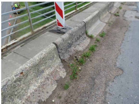
2.5 pav. Atitvarų bendras vaizdas dešinėje pusėje. Paviršiai nusidėvėję, vietomis matyti išlindę koroduojančios armatūros strypai
