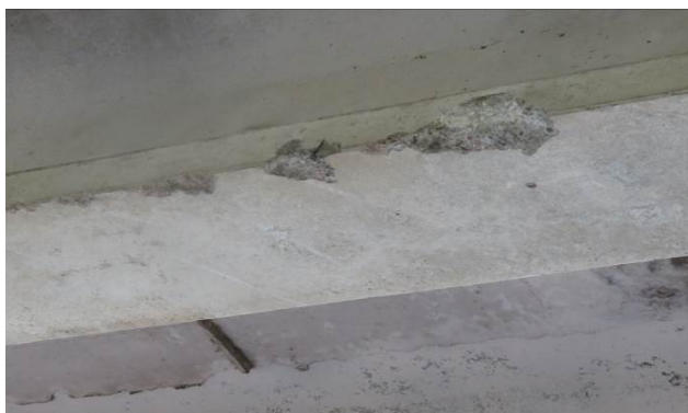
2.14 pav. Mechaniškai pažeista antrojo tarpatramio perdangos 4 sija skaičiuojant nuo dešinės pusės
