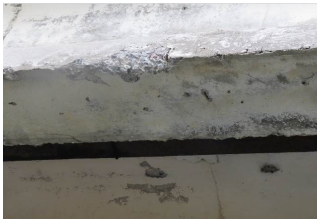
2.18 pav. Mechanškai pažeista antrojo tarpatramio perdangos 8 sija skaičiuojant nuo dešinės pusės
