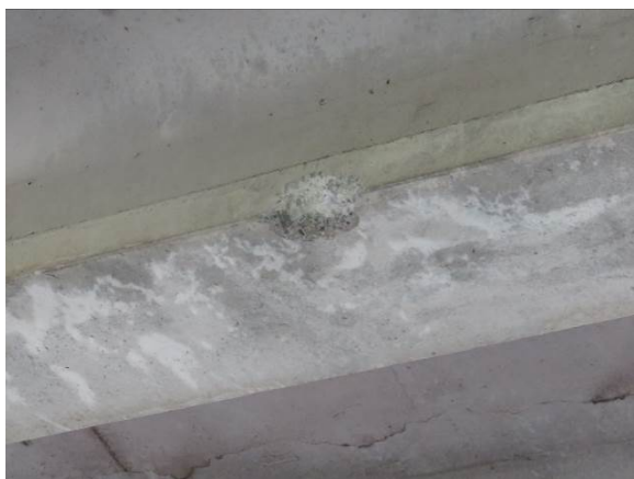
2.15 pav. Mechaniškai pažeista antrojo tarpatramio perdangos 5 sija skaičiuojant nuo dešinės pusės
