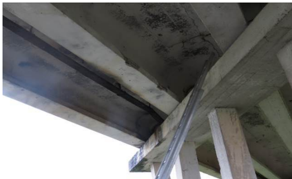
2.11 pav. Antroje sijoje, ties antra atrama, nutrupėjęs apsauginis betono sluoksnis, koroduoja į paviršių išlindę pagalbinės armatūros strypai
