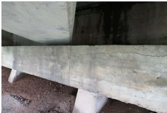
2.32 pav. Išilginiais plyšiais papleišęs 4 atramos rygelis tarp 1 ir 3 sijų
