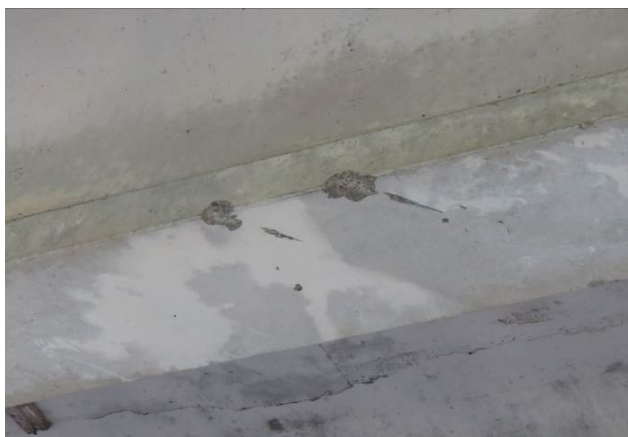
2.16 pav. Mechaniškai pažeista antrojo tarpatramio perdangos 6 sija skaičiuojant nuo dešinės pusės
