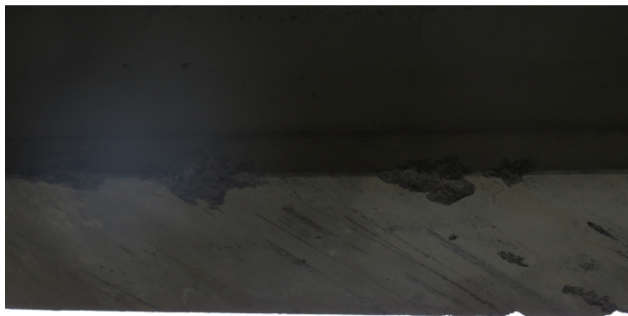
2.12 pav. Mechaniškai pažeista antrojo tarpatramio perdangos 1 sija dešinėje viaduko pusėje. Sijos apačioje numuštas apsauginis betono sluoksnis
