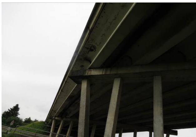
2.7 pav. Hidroizoliacija yra pažeista. Tarp kraštinių sijų plokštėje ir po šaltilčiais išsisunkę karbonatiniai produktai
