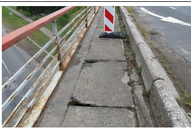
2.5 pav. Šalitilčio bendras vaizdas kairėje pusėje. Plokščių tarpai nesumonolitinti, nuskilę kraštai, koroduoja į paviršių išlindę armatūros strypai. Turėklai prarūdiję kiaurai, nestabilūs
