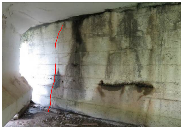
2.26 pav. Supleišėjusi 1 atramos atkaltė tarp 1 ir 2 sijų. Atkaltėje atsivėręs normalinis 0,50 mm pločio plyšys
