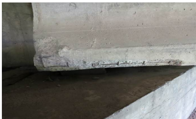
2.20 pav. Nutrupėjęs trečiojo tarpatramio perdangos antros sijos galo (virš ketvirtos atramos) apsauginis betono sluoksnis. Matosi į paviršių išlindę pagalbinės armatūros strypai
