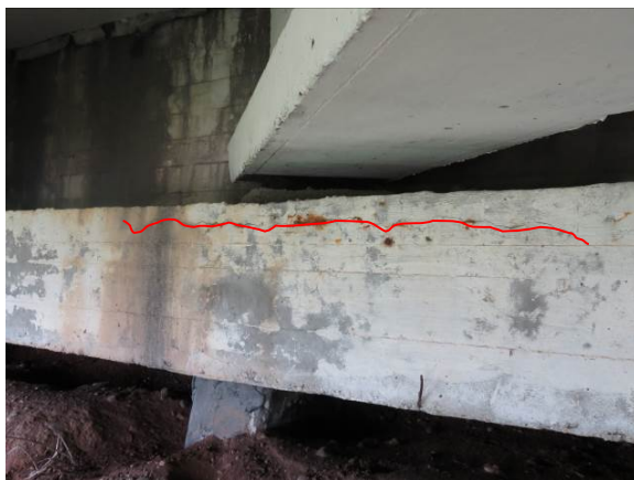
2.22 pav. Pirmos atramos rygelis. Rygelyje atsivėrę išilginiai plyšiai
