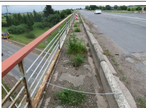
2.4 pav. Šalitilčio bendras vaizdas dešinėje pusėje. Plokščių paviršiai nusidėvėję, vietomis jose susiformavusios gilios skylės, koroduoja armatūra. Turėklai prarūdiję kiaurai, nestabilūs
