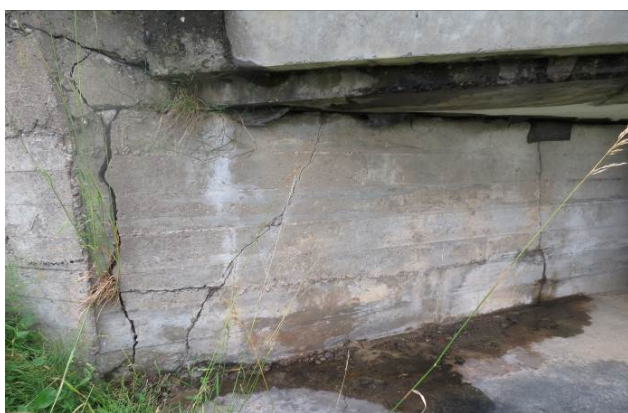
2.35 pav. Ketvirtos atramos atkaltės gale, kairėje pusėje, atsivėręs 3 cm pločio normalinis plyšys, šalia jo yra atsivėręs įstrižas plyšys
