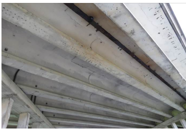
2.8 pav. Vandens nuleidimo šulinėlių vamzdžiai yra per trumpi ir stipriai pažeisti korozijos. Metalinis latakas, po šulinėliais, daugelyje vietų prarudijęs kiaurai
