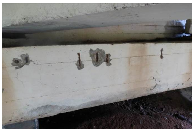
2.23 pav. Pirmos atramos rygelis. Vietomis rygelio paviršiuje atsokęs ir nukritęs apsauginis betono sluoksnis, koroduoja pagalbinės armatūros strypai
