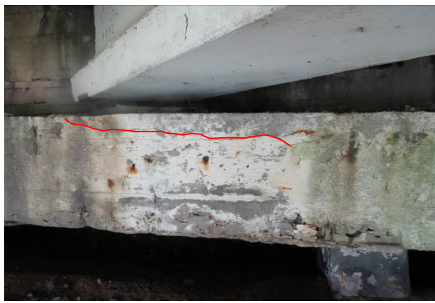
2.22 pav. Pirmos atramos rygelis. Rygelyje atsivėrę išilginiai plyšiai
