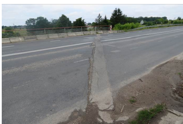
2.3 pav. Kiauras deformacinis pjūvis virš ketvirtos atramos
