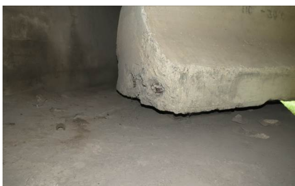
2.21 pav. Nutrupėjęs trečiojo tarpatramio perdangos trečios sijos galo (virš ketvirtos atramos) apsauginis betono sluoksnis. Matosi gniūžtės
