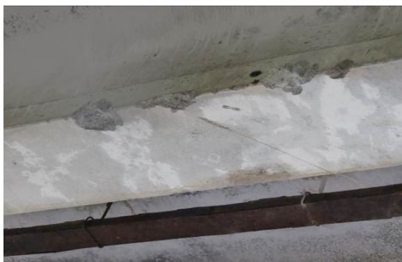
2.13 pav. Mechaniškai pažeista antrojo tarpatramio perdangos 3 sija skaičiuojant nuo dešinės pusės
