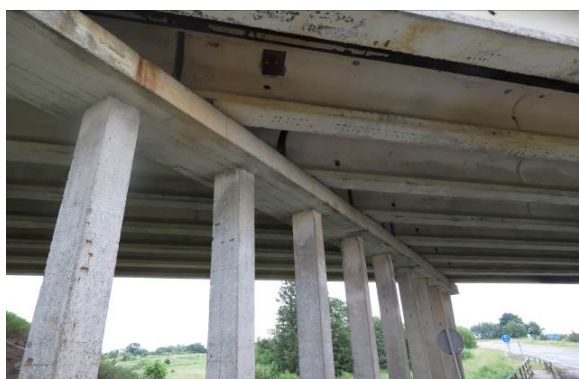
2.30 pav. Antros atramos kolonų bendras vaizdas. Daugelyje vietų atšokęs ir nukritęs apasuginis betono sluoksnis, koroduoja pagalbinės armatūros strypai
