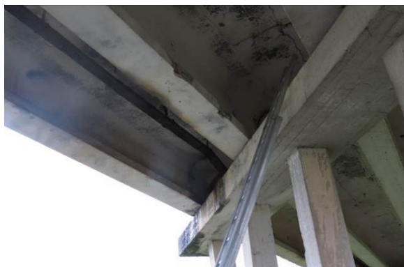
2.28 pav. Šlampa antros atramos rygelio galas kairėje viaduko pusėje. Galas patakuotas žaliais patakais
