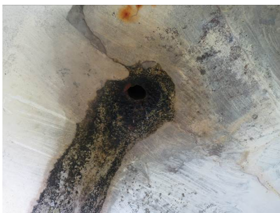
2.8 pav. Vandens nuleidimo šulinėlių vamzdžiai yra per trumpi ir stipriai pažeisti korozijos. Metalinis latakas, po šulinėliais, daugelyje vietų prarudijęs kiaurai
