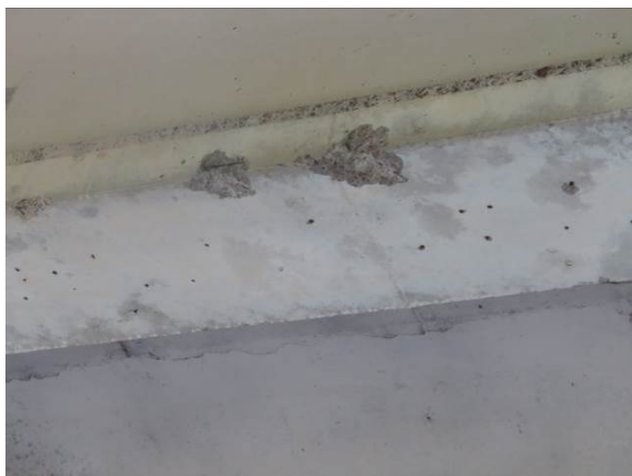
2.17 pav. Mechanškai pažeista antrojo tarpatramio perdangos 7 sija skaičiuojant nuo dešinės pusės
