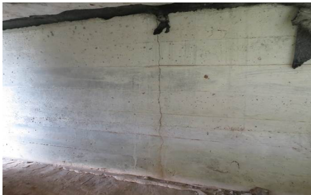
2.33 pav. Ketvirtos atramos atkaltėje tarp 7 ir 8 sijų atsivėręs 1,65 mm pločio normalinis plyšys
