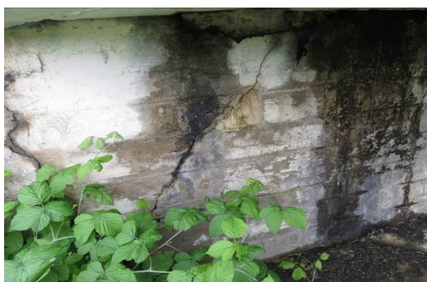
2.25 pav. Supleišėjusi 1 atramos atkaltė dešinėje pusėje, ties 1 sija. Atkaltėje atsivėręs 2,50 mm pločio įstrižas plyšys
