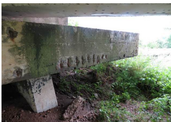
2.24 pav. Šlapias 1 atramos rygelio galas kairėje pusėje. Rygelio apačioje nutrupėjęs apsauginis betono sluoksnis, koroduoja pagalbinė armatūra
