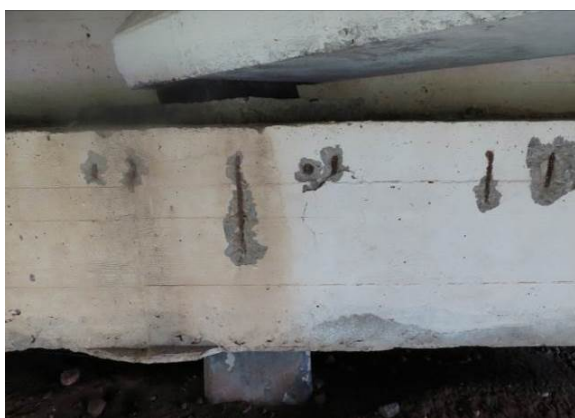
2.23 pav. Pirmos atramos rygelis. Vietomis rygelio paviršiuje atsokęs ir nukritęs apsauginis betono sluoksnis, koroduoja pagalbinės armatūros strypai
