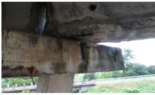
2.29 pav. Šlampa antros atramos rygelio galas dešinėje pusėje. Rygelyje, po 8 sija, paleišėjęs ir atšokęs apsauginis betono sluoksnis, oroduoja pagalbinės armatūros strypai
