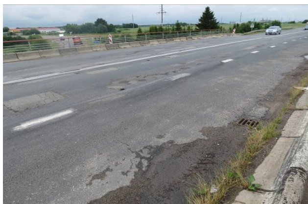
2.1 pav. Dangos bendras vaizdas. Danga įdubusi, susiformavę provėžos, yra daug išdaužų. Kairėje pusėje dangoje yra sustumtu asfaltbetonio gūbrių
