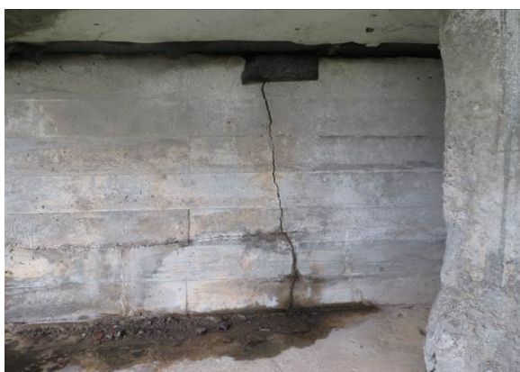
2.34 pav. Ketvirtos atramos atkaltėje, ties 8 sija atsivėręs 6 mm pločio normalinis plyšys
