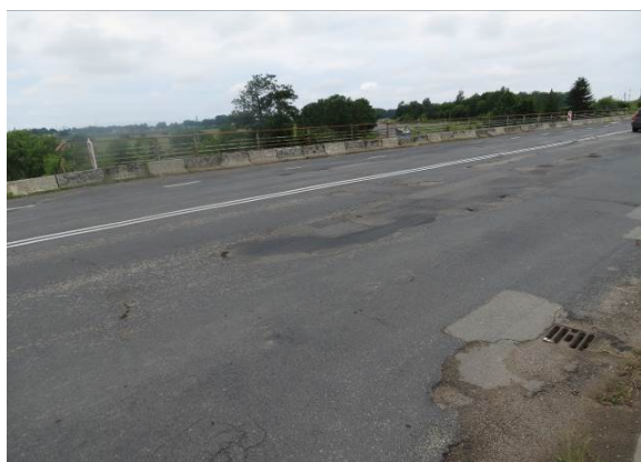
2.1 pav. Dangos bendras vaizdas. Danga įdubusi, susiformavę provėžos, yra daug išdaužų. Kairėje pusėje dangoje yra sustumtu asfaltbetonio gūbrių
