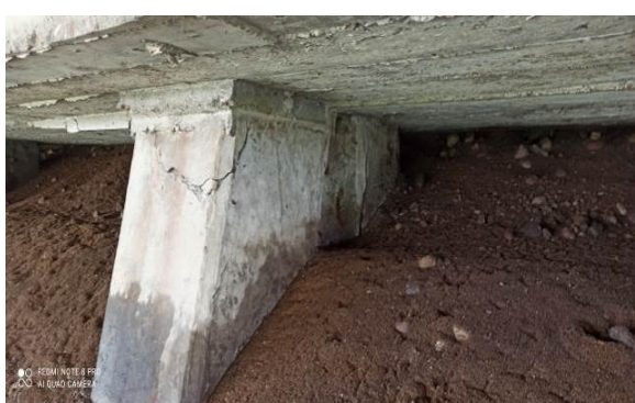
2.36 pav. Papleišę 4 atramos poliai. Atšokęs apsauginis betono sluoksnis, koroduoja pagrindinės ir pagalbinės aramtūrų strypai
