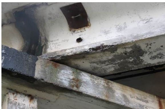
2.19 pav. Antrojo tarpatramio perdangos 8 sijos galas virš 3 atramos. Papleišęs apsauginis betono sluoksnis, koroduoja pagalbinė armatūra
