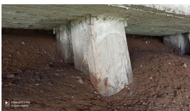
2.36 pav. Papleišę 4 atramos poliai. Atšokęs apsauginis betono sluoksnis, koroduoja pagrindinės ir pagalbinės aramtūrų strypai
